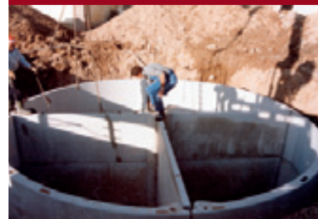
DREIKAMMERSYSTEM ZUR ABWASSERENTSORGUNG
